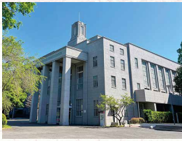
マリアンホール
