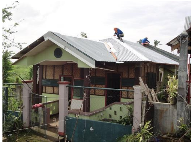
トタン屋根の取り付けられているスタッフハウス
